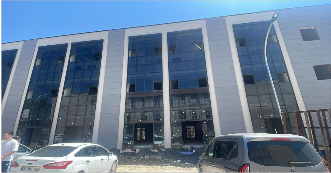
Merkezi Derslik Binası
